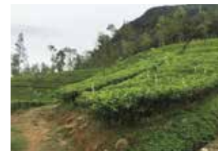
カバークロープ (右側法面)
